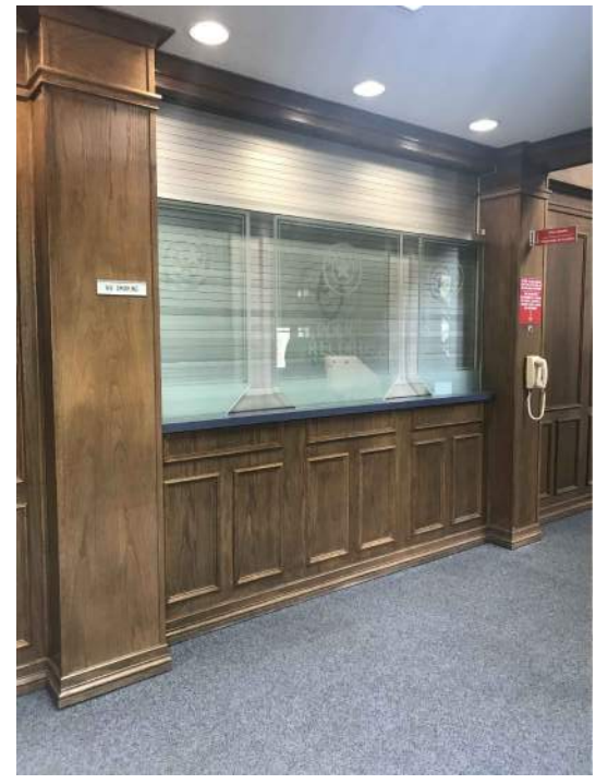
B3 MUNICIPAL COURTS PHOTO SCALE: N.T.S.
